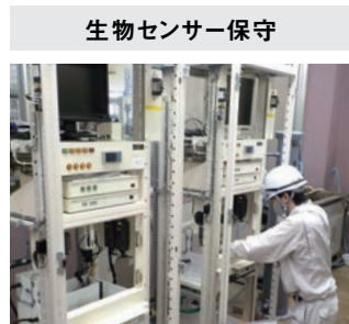
水質監視用生物センサーの分解整備や部品交換を実施
