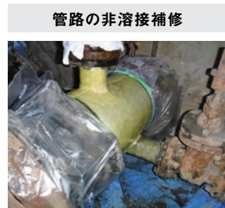
FRPを用いて老朽配管や分岐配管等の難施工箇所を補修
