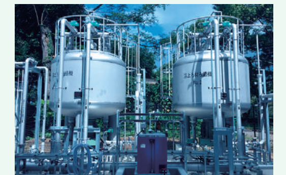
● 多くの水族館で採用されている節水型ろ過機「FMフィルタ」
