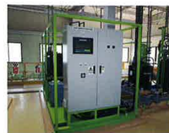
●精密ろ過膜装置(MF) 浸出水中に含まれる浮遊物質(SS)やSS性ダイオキシン等を精密ろ過膜を用いて除去します。
