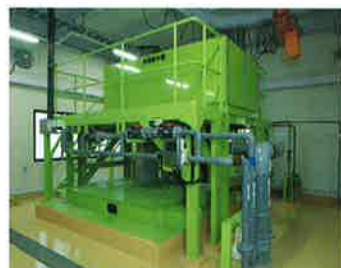
●汚泥脱水機 凝集沈殿槽で沈殿分離した汚泥を濃縮した後、脱水機により含水率85%以下の脱水ケーキとして、搬出します。
