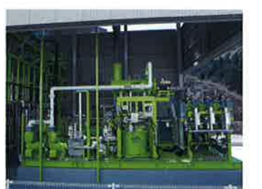
●エコ次亜生成装置 電気透析濃縮装置から回収した塩類を用いてエコ次亜(消毒剤)を生成します。
