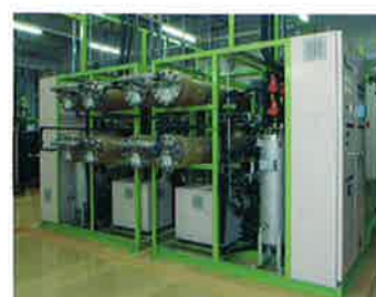
●逆浸透膜装置(RO) 色度、有機物、細菌、窒素、溶解性ダイオキシン、塩類等を逆浸透膜を用いて除去します。
