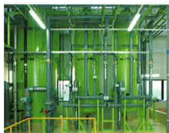
●散気式ろ過槽・活性炭吸着塔 散気式ろ過槽ではBODを分解し、活性炭吸着塔では、色度やCODを吸着除去します。
