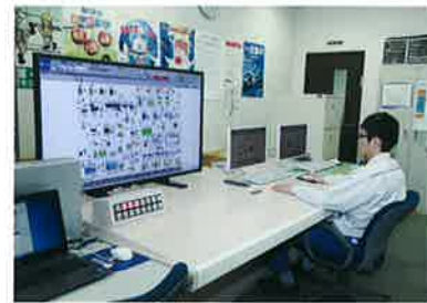
●中央監視室 浸出水処理棟、表流水・簡易浄水処理棟、エコ次亜生成設備の処理状況、各機器の動作状況を監視しています。
