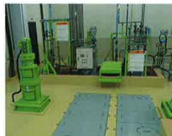
●凝集沈殿処理設備 浸出水に含まれる浮遊物質(SS)やカルシウム分等は凝集剤等を添加することで、凝集沈殿させて除去します。
